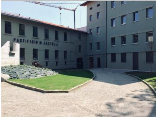
Le pavimentazioni esterne comuni saranno realizzate in **calcestre** e saranno delimitate da cordatura costituita da elementi in cemento. La pavimentazione sarà dotata di pozzetti con grigliati in ghisa e di canalette componibili grigliate carrabili posizionati in quantità sufficiente a garantire il deflusso delle acque meteoriche.
