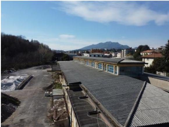
Sulle coperture dei caselli, del corpo principale e del corpo a c, originariamente piane, è stato applicato un rivestimento superiore in lastre di cemento-amianto con sottostante struttura in muricci.
