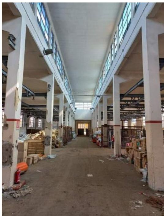
Struttura in muratura portante in laterizio in buono stato di conservazione.
